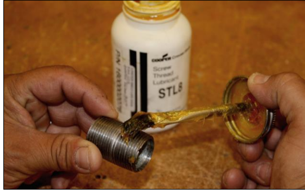
Fig 21. Applying conduit lubricant
